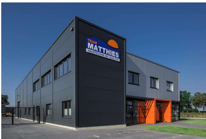
Das 2016 bezogene Firmengebäude der Team Matthies GmbH in Tostedt
